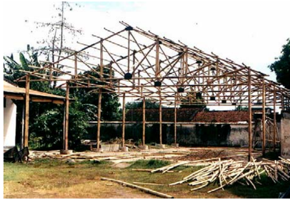
Gambar Kuda-kuda Bambu dengan Bentang 12 m
